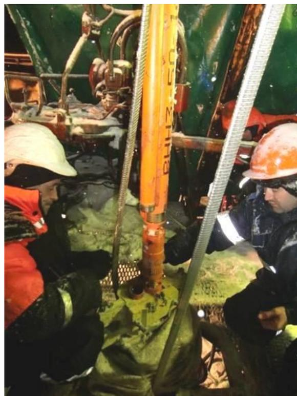
Рис. 12. Монтаж установки ОРЭ
