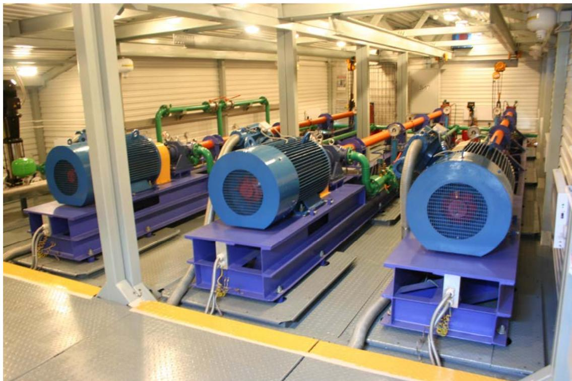
Рис. 7. Станции поддержания пластового давления
