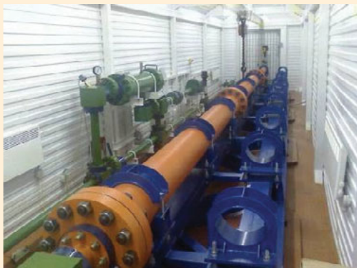
Рис. 3. Установки с погружным электродвигателем
