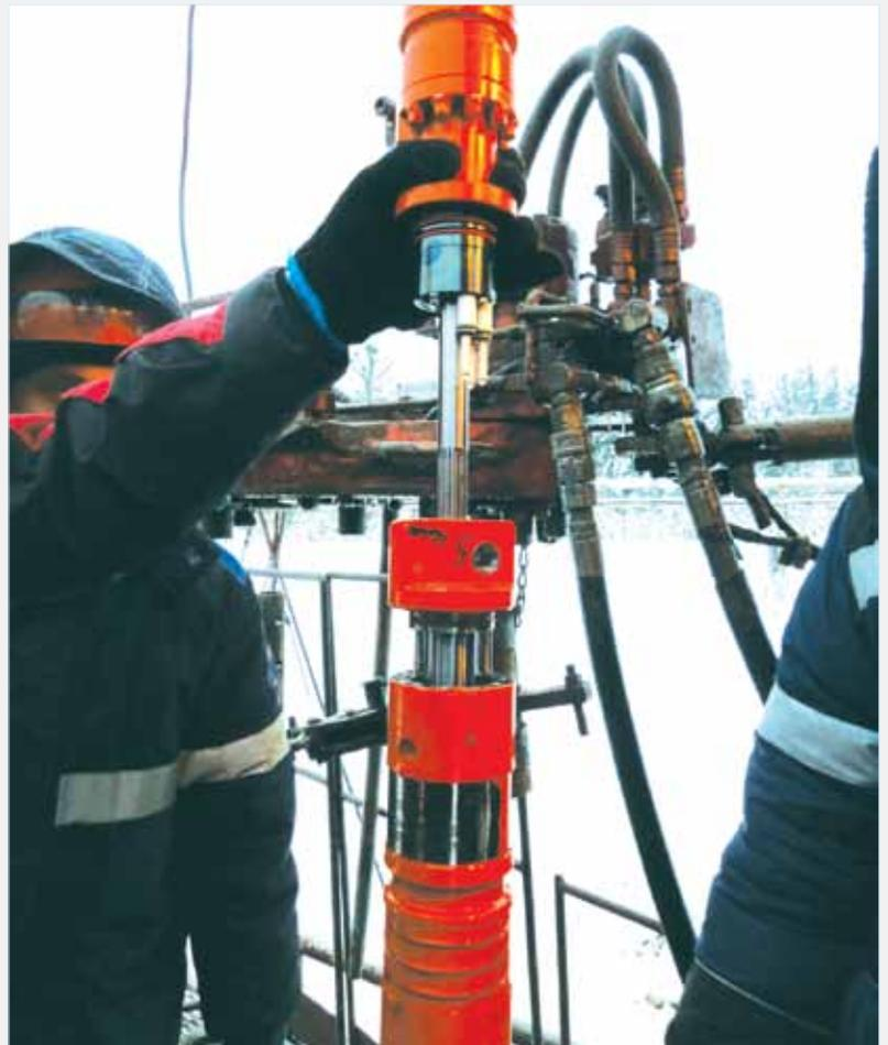
Рис. 4. Монтаж установки 2А габарита
