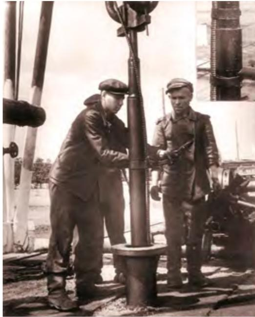
Монтаж погружного насоса в скважину
