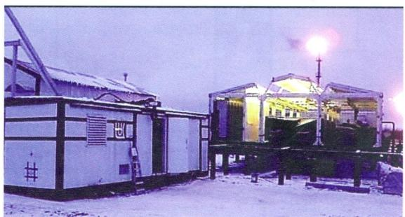
**Рис. 8. Модульная установка центробежного горизонтального насоса (УЦГН)**
