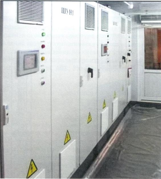
**Рис. 5. Сенсорная панель контроллера СУ**
