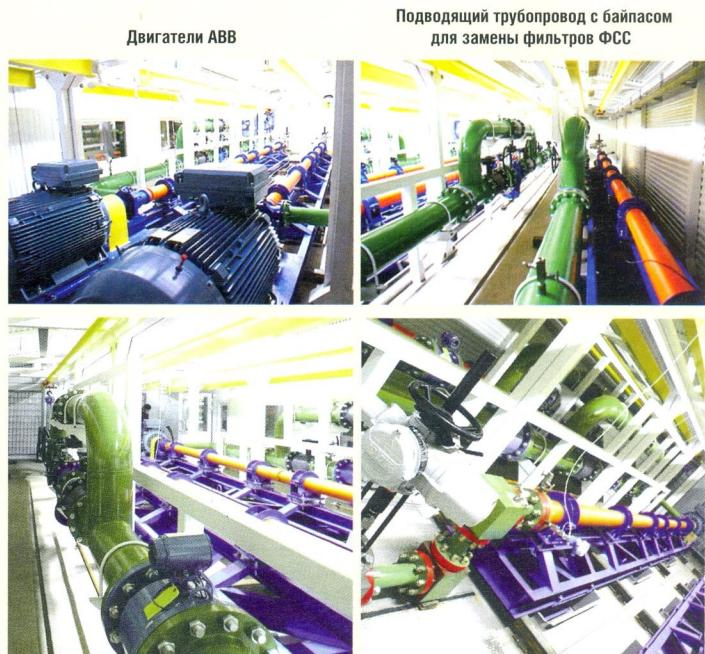
Рис. 10. Станция для водогазового воздействия
