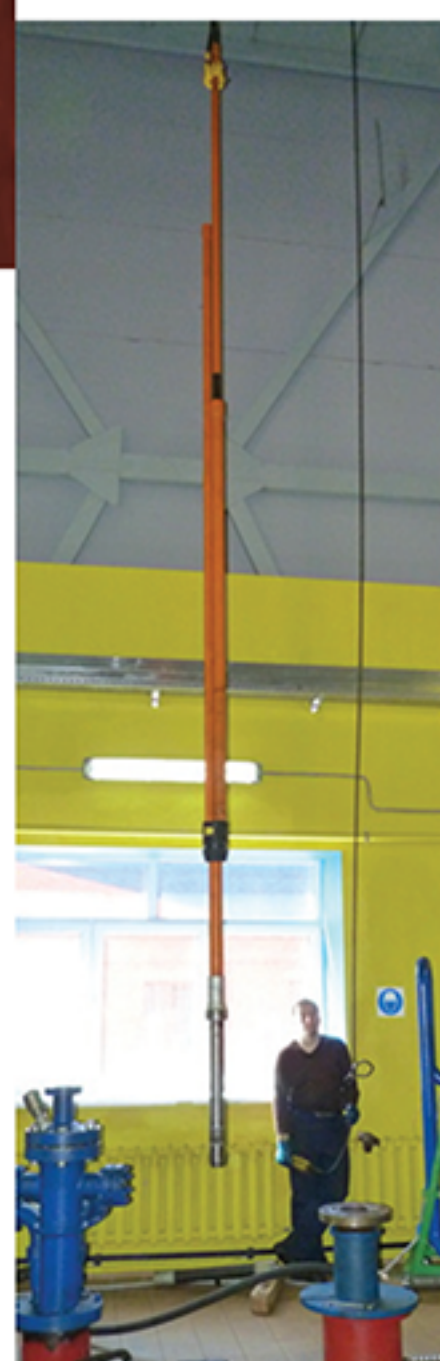
Монтаж системы дуальной
