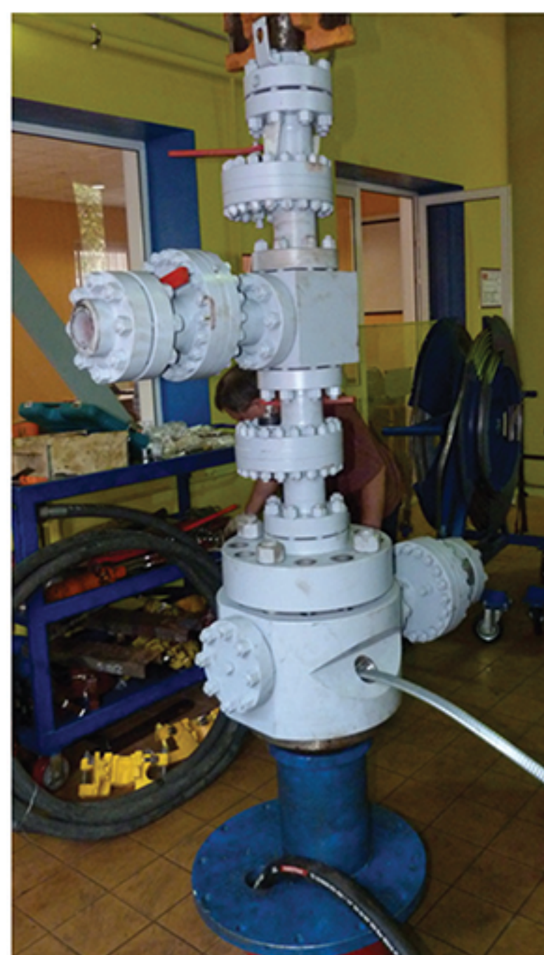
Монтаж арматуры устьевой
