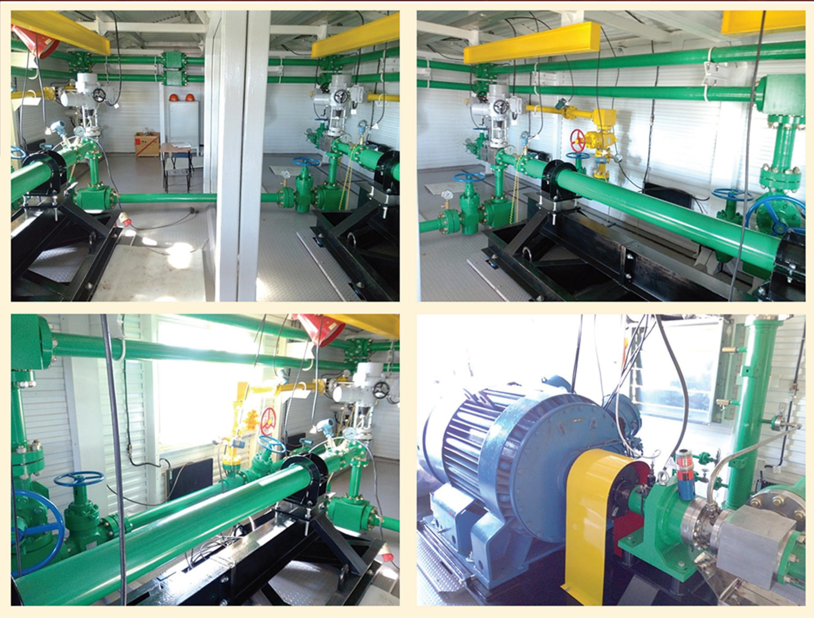
ного двигателя в качестве привода взамен погружного, использовавшегося ранее. На момент подготовки настоящей статьи ресурсные испытания успешно завершились, и можно с большой уверенностью говорить о том, что насосные агрегаты будут успешно работать в широком диапазоне давлений. В качестве дожимных насосных станций новые агрегаты с наземным двигателем смогут работать с входным давлением среды до 210 атмосфер.
