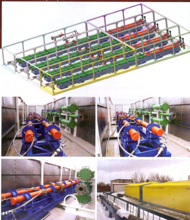
Рис. 6. МКНС производительностью 12500 м 3 /сут (ОАО НК «Роснефть»)
